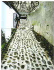
石積みの練り堀 石と泥と漆喰でできたこの堀は、 埋してもまた自然に運る素材でできている。 祝島ではこの練り堀の修復事業等を 島民自身の手で行うなど、自分たちの 文化を守る行動が行われている。
